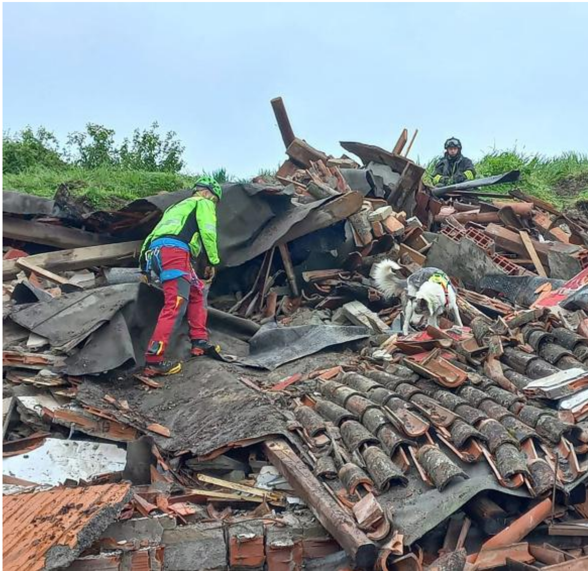
La casa crollata a Fontanelice (Bologna), sotto la quale è morto un uomo di 78 anni; a destra, un intervento dei soccorritori a Faenza per portare in salvo dalla piena due residenti con un gommone
